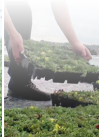
TOITURES VERTES dalles pré-cultivées de sédum
